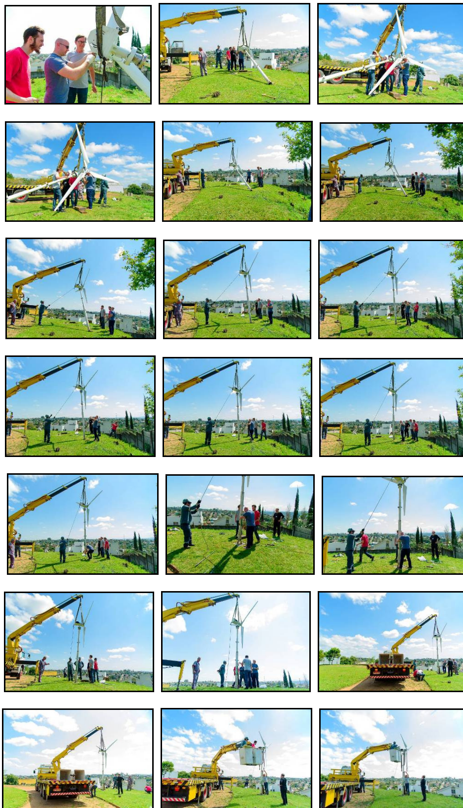
Figura 89 – Instalação Aerogerador Escola Liberato
