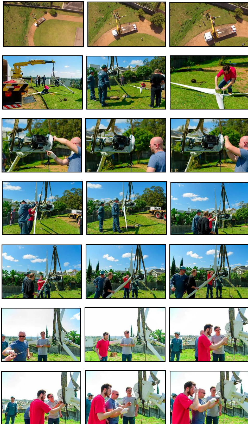
Figura 88 – Instalação Aerogerador Escola Liberato
